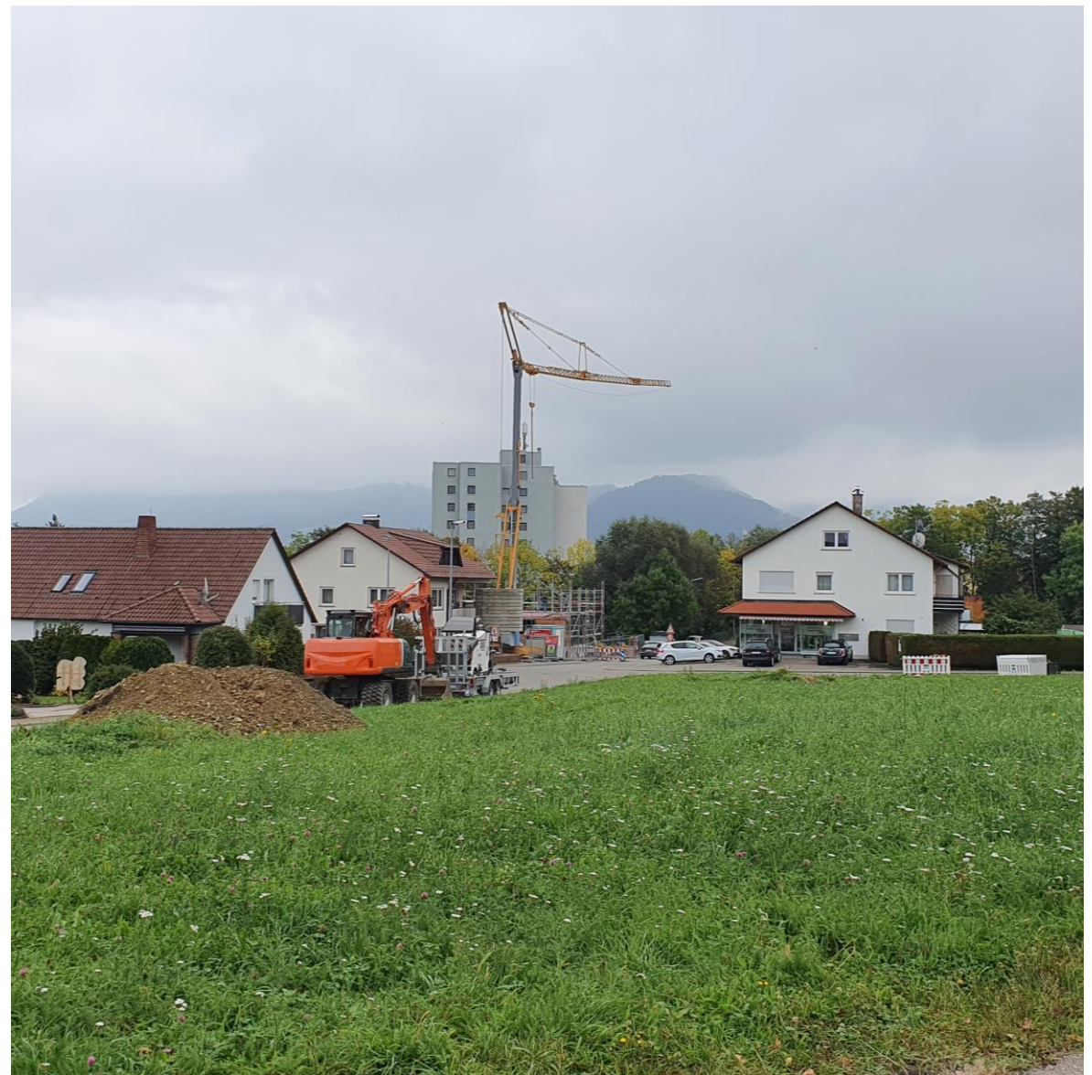
Neubau Nahversorger mit Wohnungen
