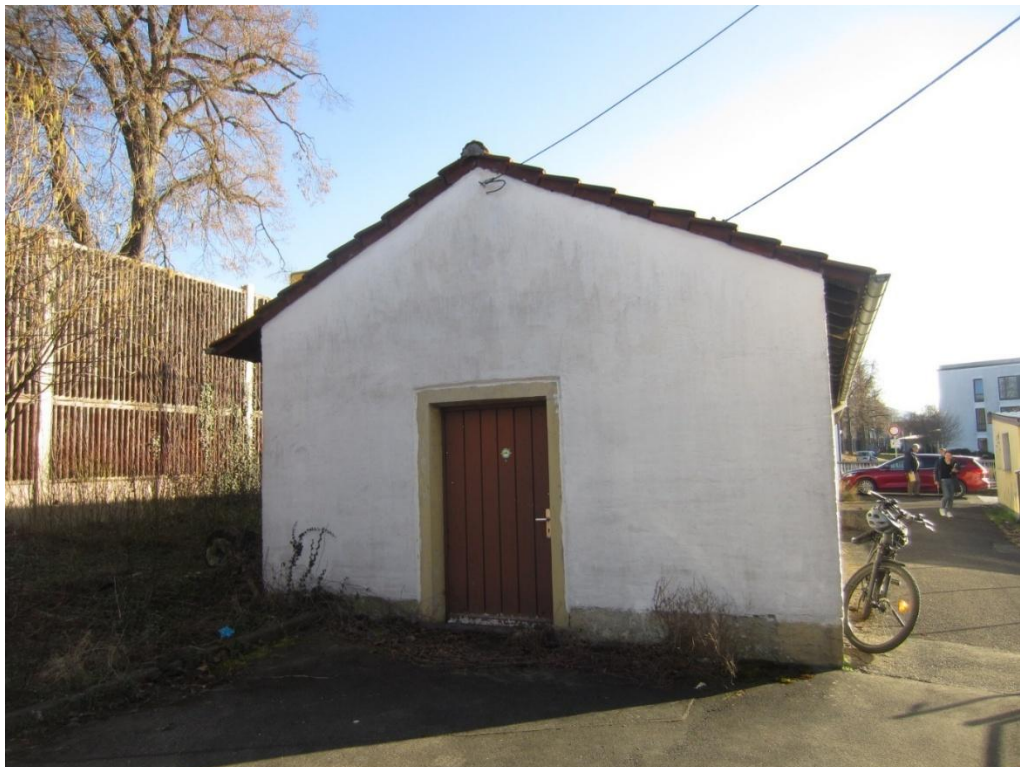
Seitenansicht (Nordansicht), Standpunkt auf der Straße (Im Siechengarten)
