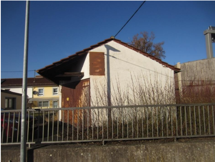
Straßenansicht (Südansicht), Standpunkt auf der Straße (Röslerweg)
