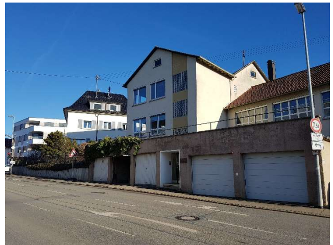
Foto 2: Nordwestliche Fassadenseite mit Garagen entlang der Eckenfelderstraße
