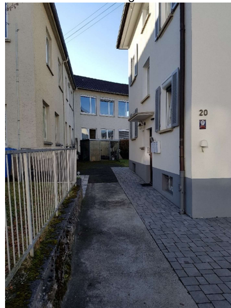
Foto 8: Gebäudezugang (betoniert, gepflastert), Ziergarten im hinteren Bereich
