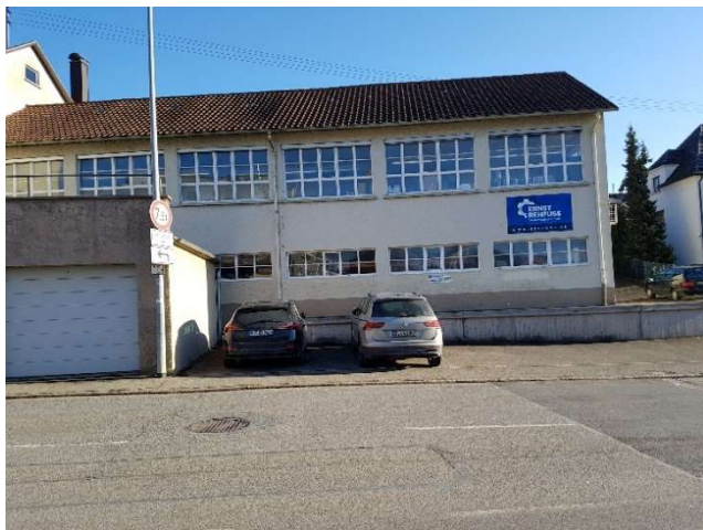
Foto 3: Betriebsgebäude mit Jalousien als potenzielle Fledermausquartiere
