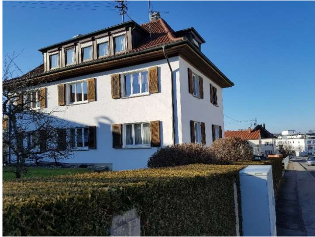
Foto 11: Nordost- bzw. Südostfassade, viele Klappläden, Rollladenkästen an den Gaubenfenstern
