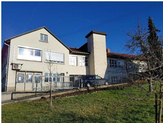
Foto 1: Südwestliche Fassade der Betriebsgebäude
