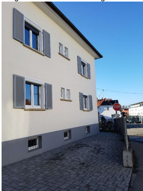
Foto 7: gepflasterter Hofbereich am Eckgebäude, permanent geöffnete Klappläden als potenzielle Fledermausquartiere
