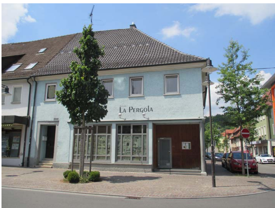
Abbildung 16: Gebäudeleerstand Friedrichstraße 74, Quelle WHS
