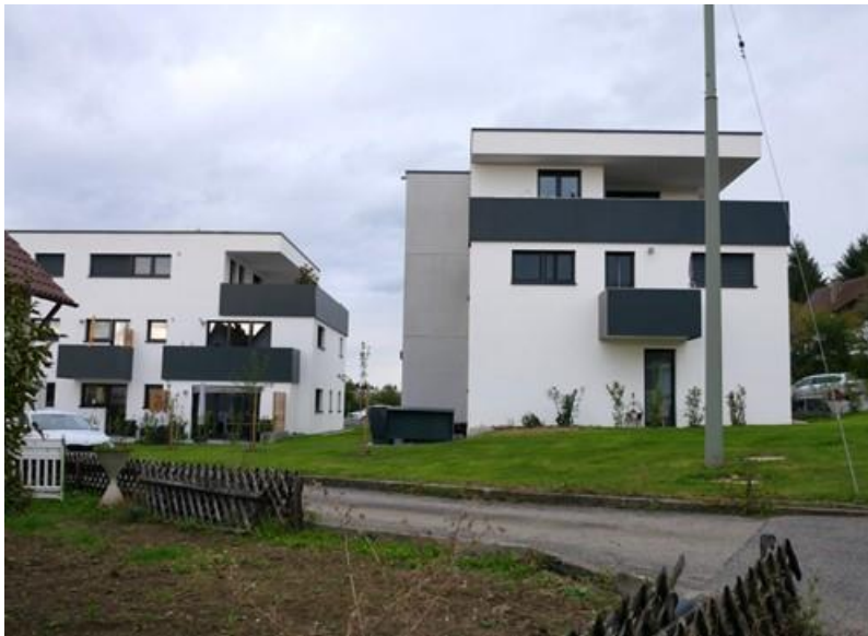
Neubau Erzinger Weg
