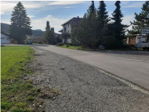
Foto 1: Blick über das Plangebiet in Richtung Westen
