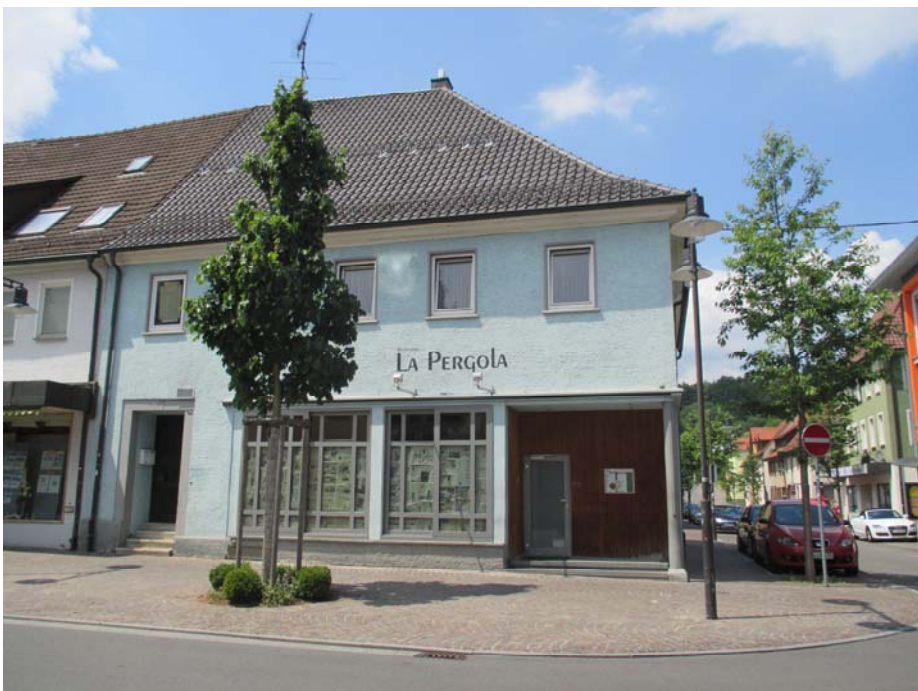
Abbildung 16: Gebäudeleerstand Friedrichstraße 74, Quelle WHS
