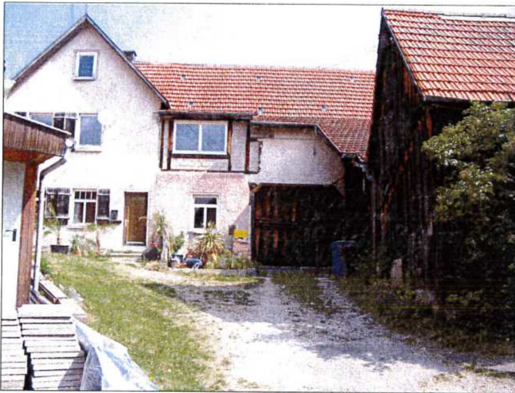
Abbildung 3: Modernisierungsbedürftiges, charakteristisches Hofgebäude
