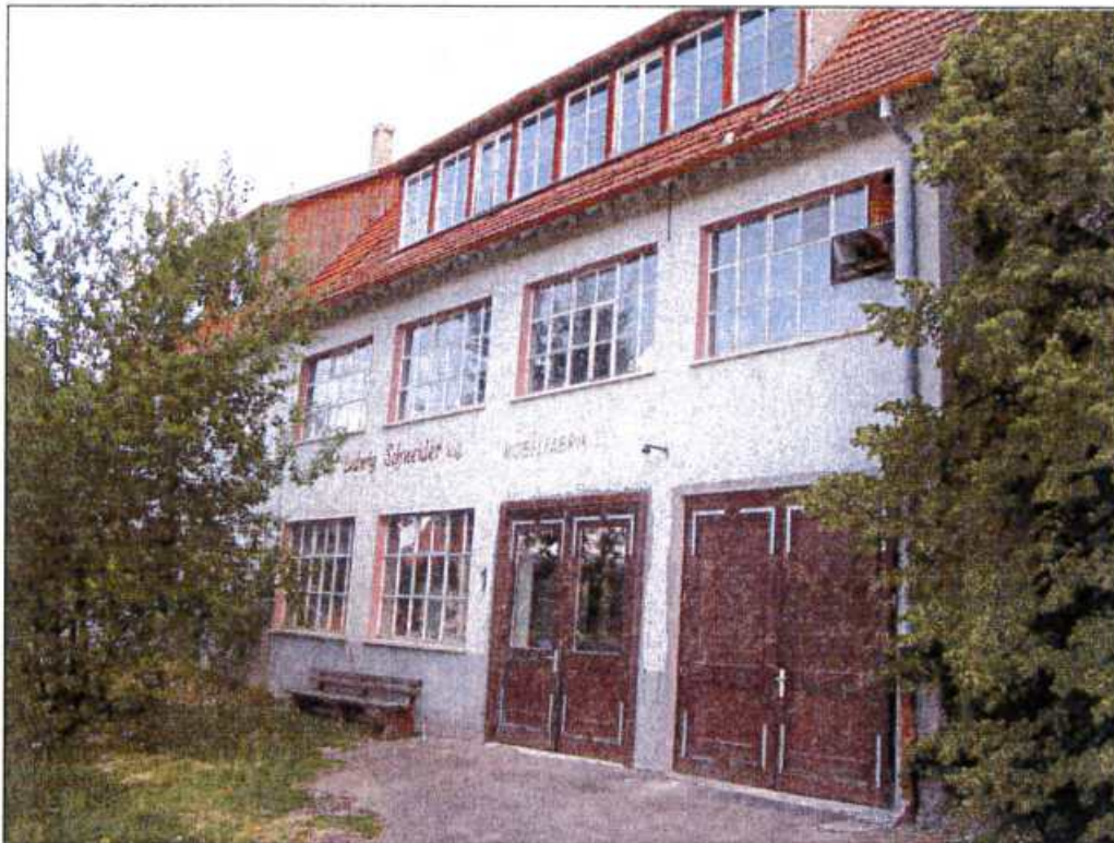
Abbildung 2: Leerstehendes Fabrikgebäude Eichbühlstraße 1
