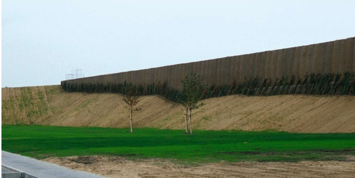
Kombination Lärmschutzwall mit Lärmschutzwand
