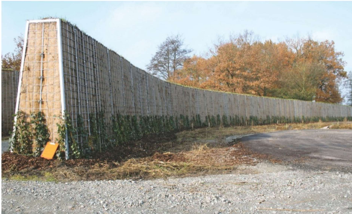
Lärmschutzwand-System – nach der Herstellung
