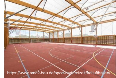
Überdachter Platz/ Freilufthalle
