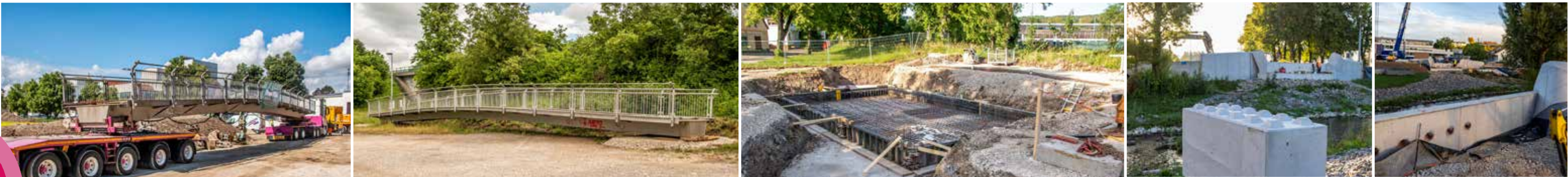
... aufgeladen ... und unweit der Bizerba-Arena zwischengelagert. Dann werden die Fundamente für die neue Brücke betoniert ... und das Widerlager fertiggestellt.
