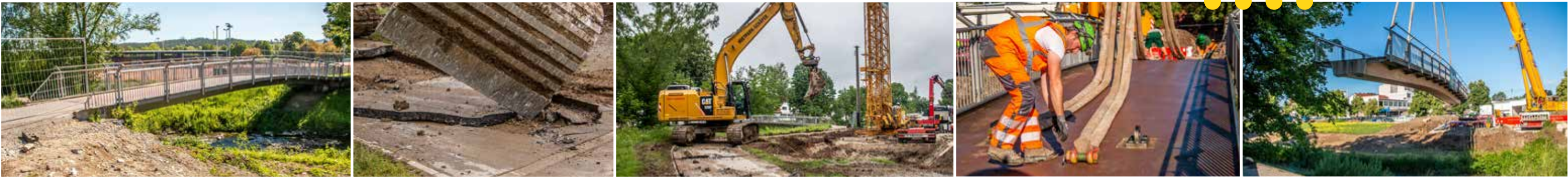
02.06.2021 Die alte Brücke vor dem Aushub. Sie wird an anderer Stelle flussabwärts als neue Querung über die Eyach wieder eingesetzt. Das Gelände wird abgetragen, um die Brückenwiderlager freizulegen. Die Brücke wird an den Trageseilen des Krans eingehängt ... ausgehoben ...
