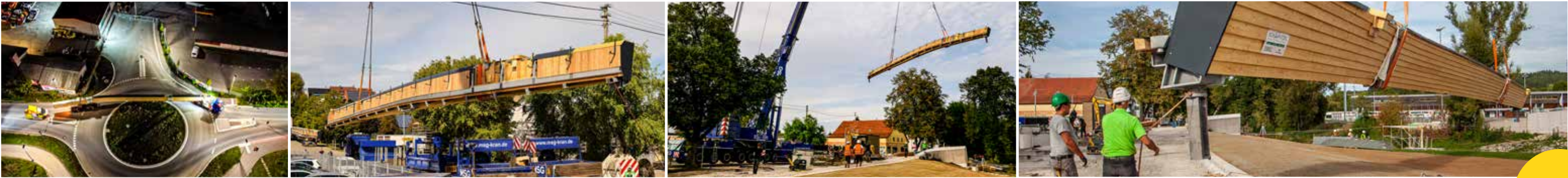
23.09.2022 Die neue Brücke wird „bei Nacht und Nebel“ gebracht, ... jeder Träger einzeln abgeladen ... und eingehoben.
