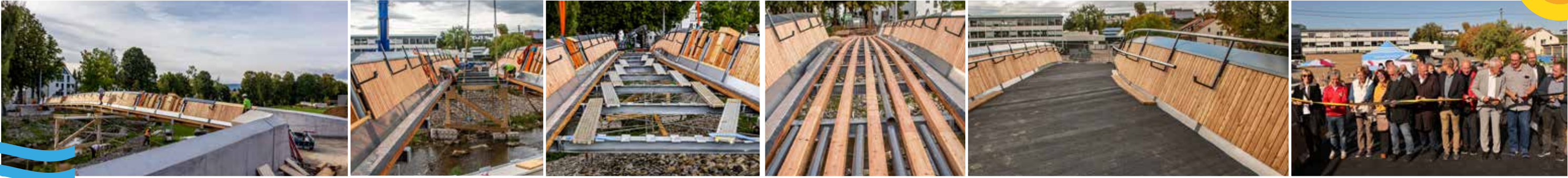
Nachdem die Träger sitzen, werden sie mit einer Stahlunterkonstruktion verbunden. Diese bietet das Auflager für den Belag. Feierliche Einweihung am 05.10.2022.
