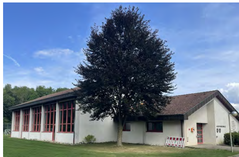
10 - Turn- und Festhalle Erzingen (Geischberghalle)
